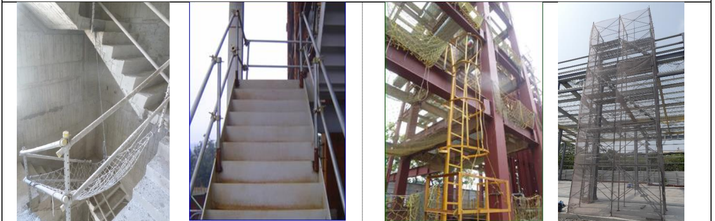
樓梯側邊開口部分應設置護欄(扶手)
